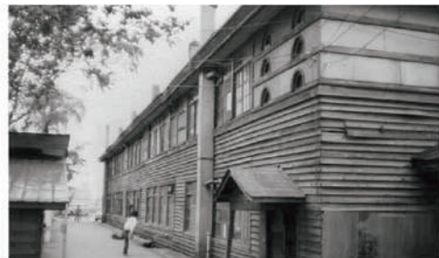
移築された北海高校2階建校舎⑦を大学部室棟として使用していた頃、1982年撮影。 文化系部室棟完成翌年の1984（昭和59）年度に解体された
